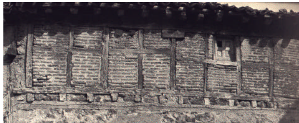
Entramado de madera con relleno de ladrillo macizo.
